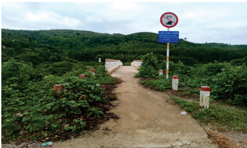
Cầu Kon HDRể xây dựng năm 2018, phục vụ nhân dân vào khu sản xuất
