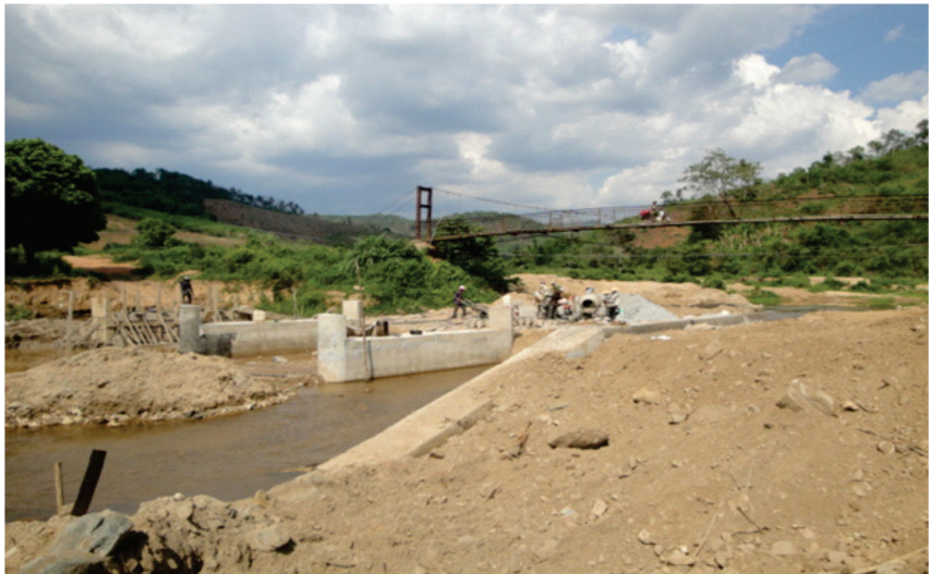
Cầu tràn Đăk Phía thi công và xây dựng năm 2013
